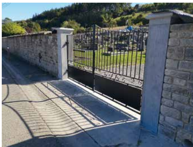
Rénovation de la porte d'entrée du cimetière de Beauraing : nouvelle grille et nouvelle entrée
